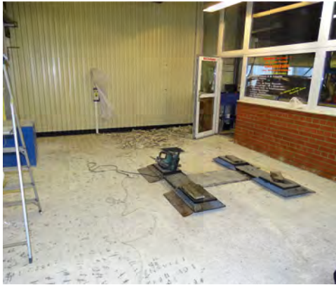
Vor dem Umbau ...
